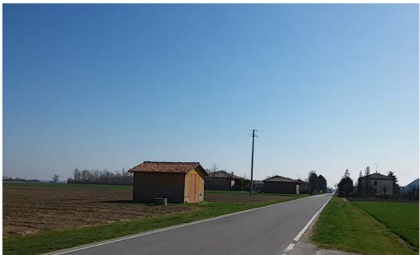
Fig. 3 si noti l'assenza totale di fossi di guardia e l'ottimo stato del piano stradale
