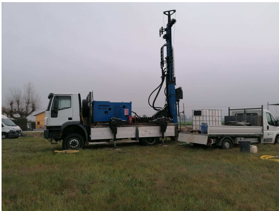
Figura 10c – Ubicazione sondaggio S1
