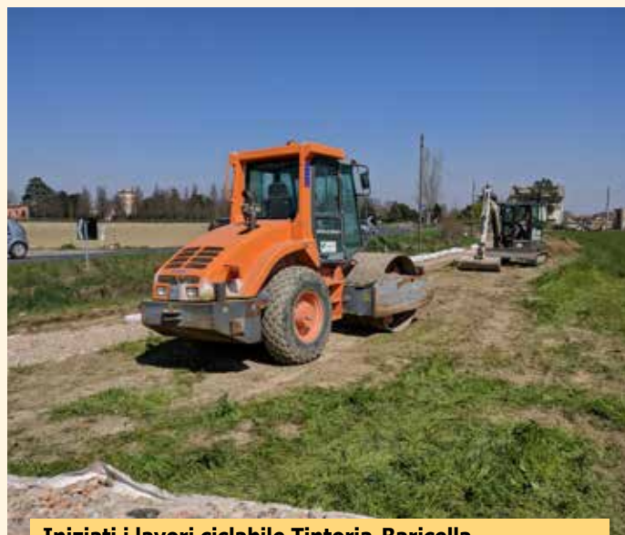
Iniziati i lavori ciclabile Tintoria-Baricella
