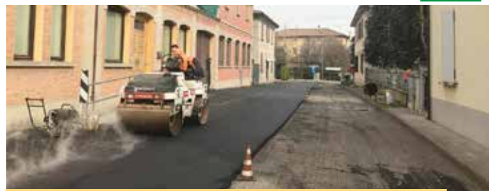
INTERVENTO 3 - Via Fabbri
