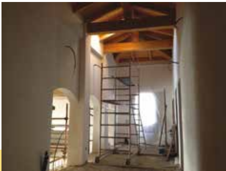
Scorcio dell'interno durante i lavori
