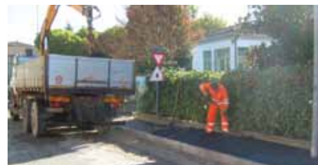
Lavori di realizzazione di un nuovo marciapiede in via Barche a Cà de Fabbri
