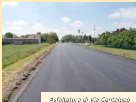
Asfaltatura di Via Cantalupo
