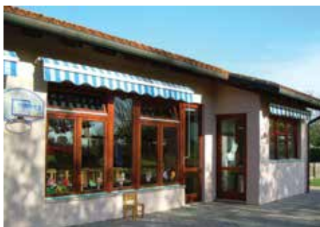
L'esterno della scuola materna di Minerbio dopo i lavori di #Scuole belle.
