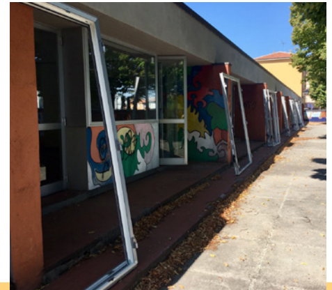
Sostituzione degli infissi della scuola media e montaggio dei nuovi per migliorare le prestazioni energetiche della scuola
