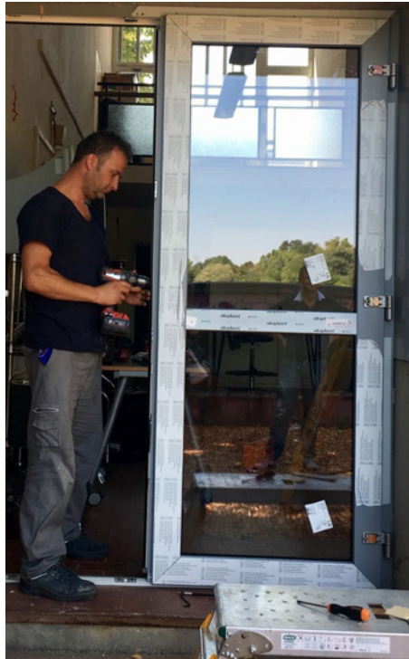
Sostituzione degli infissi della scuola media e montaggio dei nuovi per migliorare le prestazioni energetiche della scuola
