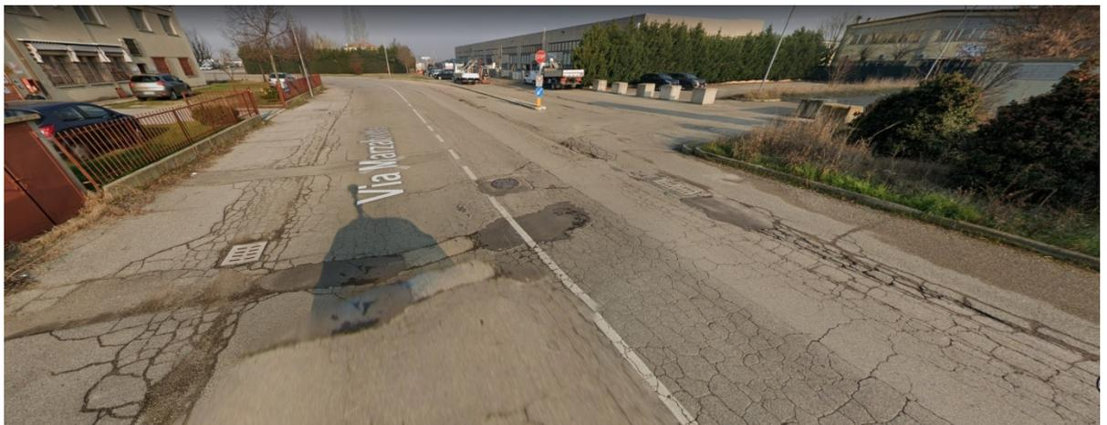
In data 21/01/2021 sono stati eseguiti dei saggi per verificare la stratigrafia della strada che hanno evidenziato una sezione piuttosto inadeguata al traffico intenso della zona industriale-artigianale.
