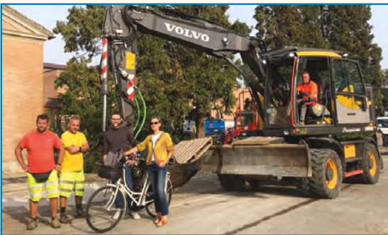
Sopralluogo del Sindaco Roberta Bonori e dell'Assessore Fabrizio Tugnoli in via Palio durante i lavori di asfaltatura e riqualificazione del parcheggio antistante il Cimitero di Minerbio - Ottobre 2022
