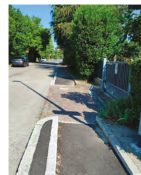
Particolari dell'intervento giugno 2023
