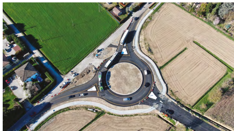
La nuova strada di collegamento allo zuccherificio inaugurata e apertura al traffico il 5 aprile 2024
